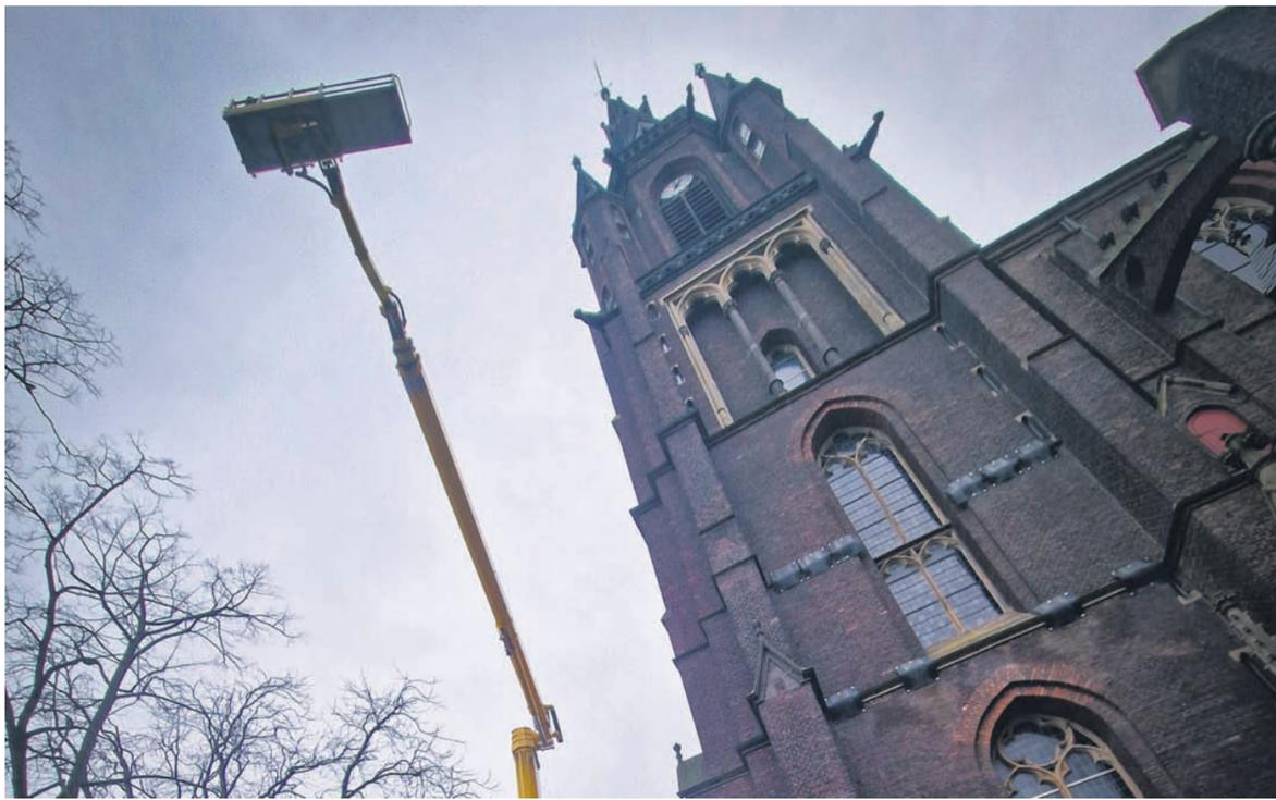
Die Sanierungsarbeiten am großen Turm der Kevelaerer Basilika gestalteten sich aufwändig. Die ausführende Fachfirma musste extra einen Spezialkran mieten und ihn per Schwerlasttransport auf den Kevelaerer Kapellenplatz bringen lassen, um dann in 95 Meter Höhe rund 25 Schieferplatten erneuern zu können. Die Arbeiten sind inzwischen abgeschlossen und die Absperrungen auf dem Kapellenplatz beseitigt.
