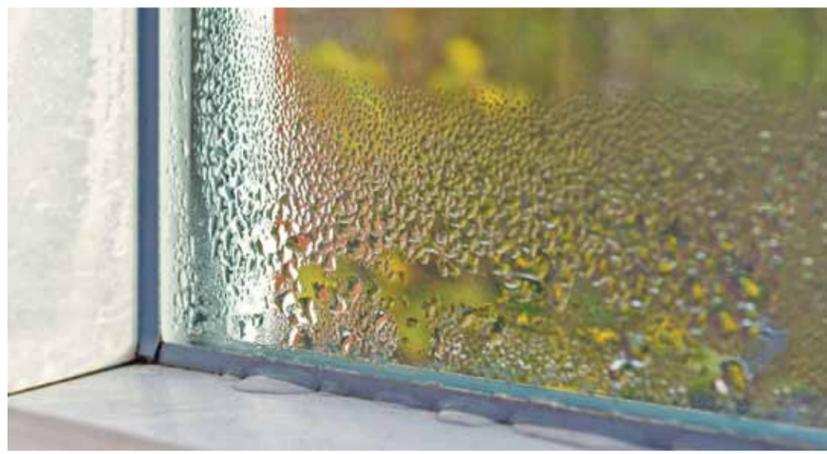
Feuchtigkeit in der Wohnung und als Ergebnis ein erhöhter Energiebedarf: Ein Austausch alter Dichtungsprofile ist dann oftmals unerlässlich.
