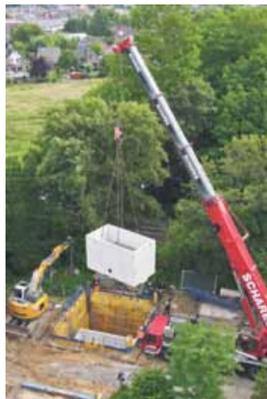
**Im Zuge der Kanalsanierungsarbeiten** wurde der Lamellenklärer eingesetzt. Foto: Stadt Goch
